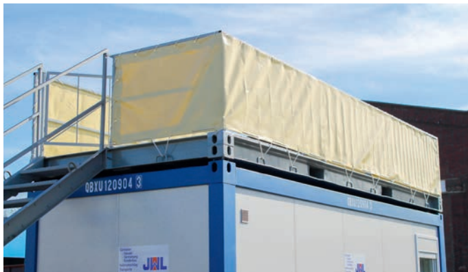
Container mit Aussichtsplattform
